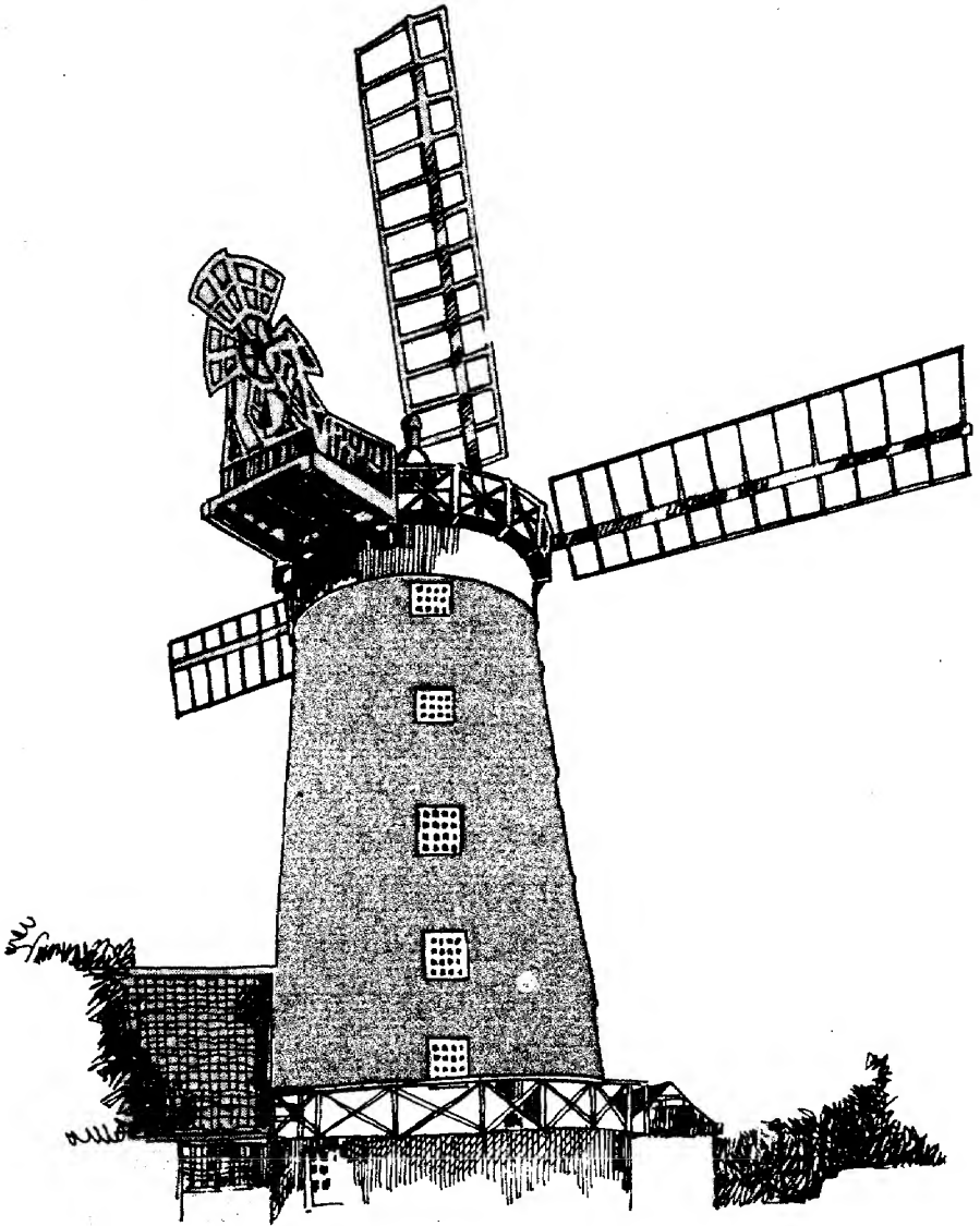
चित्र 4. घूमने वाली ऊपरी कैप सहित एक मीनार चक्की। यह पहियों पर घूमती है, और पंख-पुच्छ की सहायता से पवन की दिशा में रहती है।
